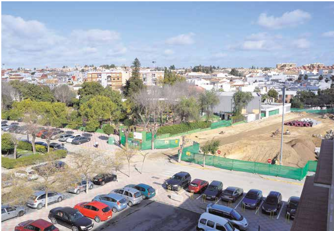
Se han habilitado nuevas plazas de aparcamiento para sustituir a las que se han perdido debido a las obras del tanque de tormentas
